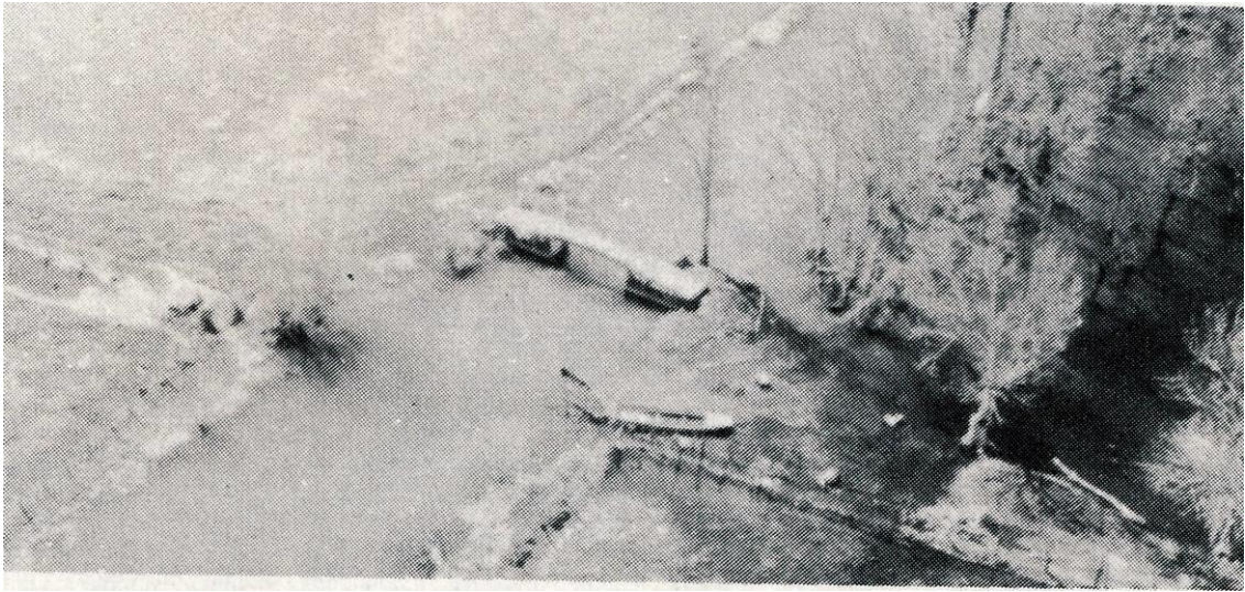
Passerelle sur le canal du Curé au sud de Nuaille
